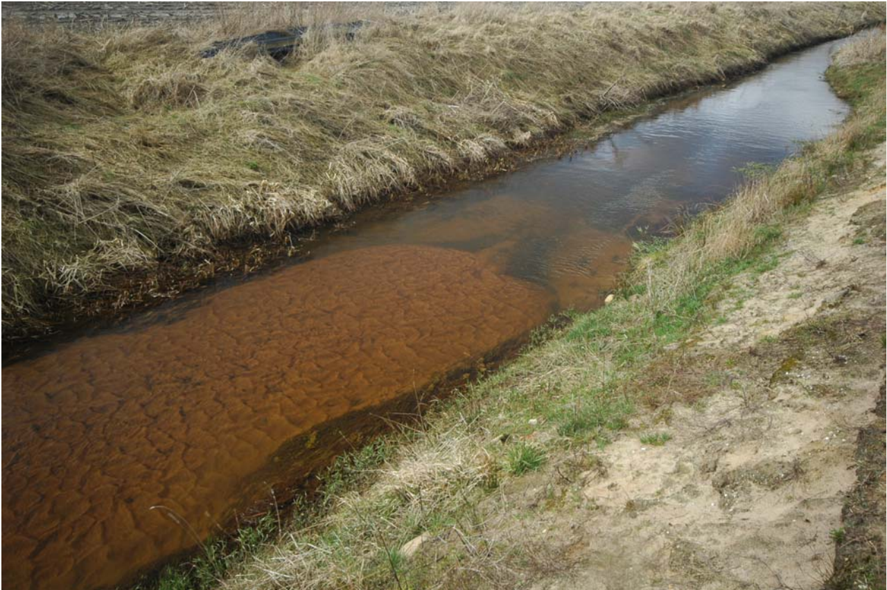
Foto 7. Sandet triller ind i sandfanget hvor det tydeligvis aflejres. Det udlagte gydegrus umiddelbart nedstrøms er derved beskyttet mod tilsanding.
