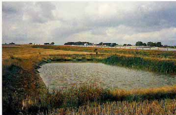
Regnvandsbassin ved motorvej.
