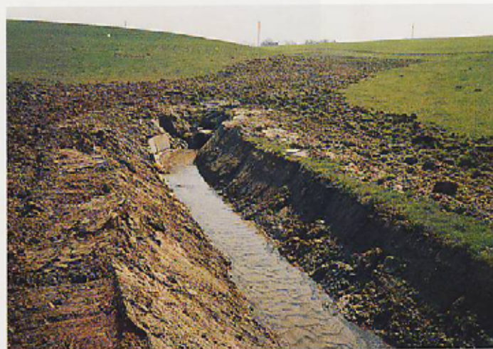
Reguleret og rørlagt bæk. Det eneste positive er, at billedet nu kan vise, hvordan man ikke skal gøre.
