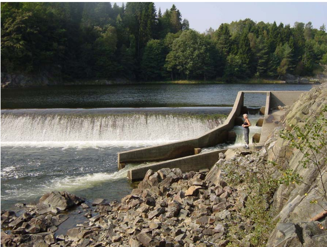
Norsk fisketrappe af bassintypen i Eidelven. Det må formodes, at mange fisk på opstrøms vandring lokkes af frivandet ved styrtet i stedet for at finde fisketrappen, som kun får tilført en mindre vandmængde. Desuden kan en del fiskearter- og størrelser ikke passere fisketrapper pga. den brudte bund og de høje vandhastigheder. Foto Jan Nielsen.
