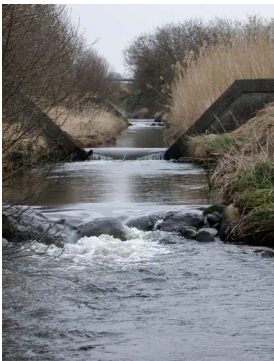
Tidligere reguleringsstyrt, hvor vandløbets fald var aftrappet med små styrt over en kort strækning. Der var dårlig faunapassage og ingen gydemuligheder. Nu er faldet udnyttet til at genskabe gydebanker med naturligt fald, og der er kommet meget ørredyngel. Hvert fald på 5 cm kan udnyttes til at anlægge 10 m gydebanke i små vandløb og op til 25 m i store vandløb
