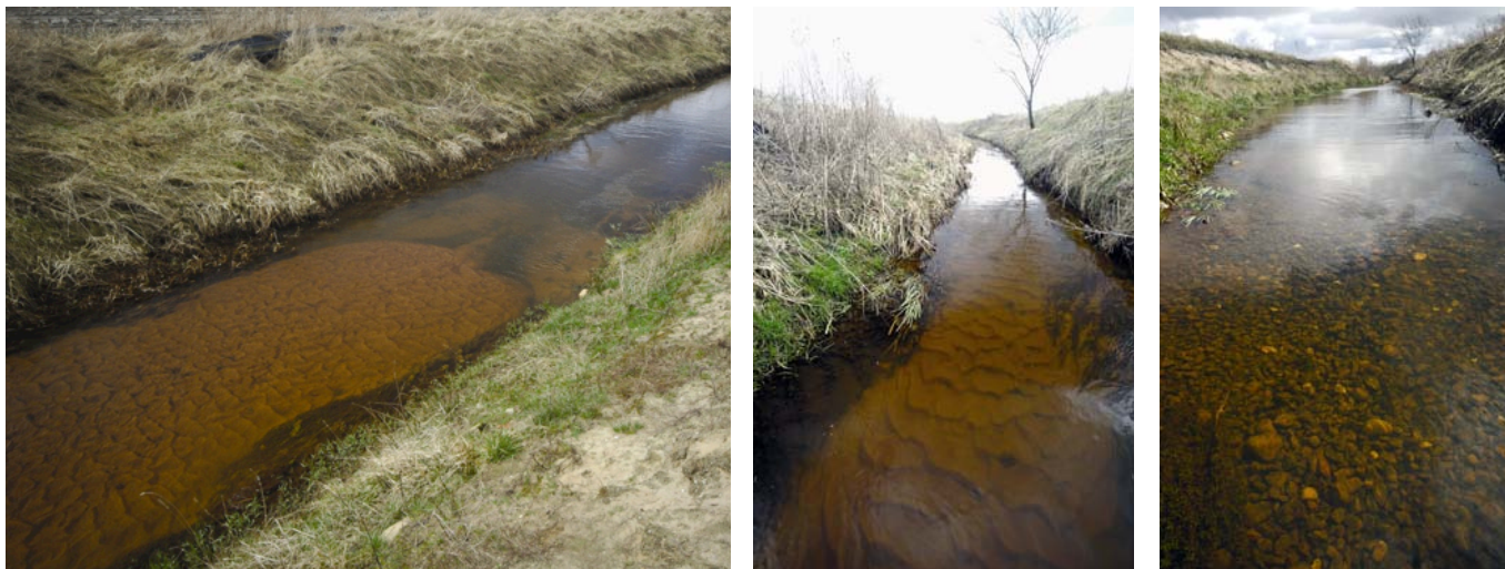
Bæk med stor sandtransport. Billederne viser et sandfang og bækken op- og nedstrøms sandfanget, som holder gydegruset rent for sand.
