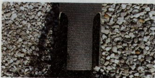
Opslidset plastrør der gør det muligt for ålene at komme ind i passet.
