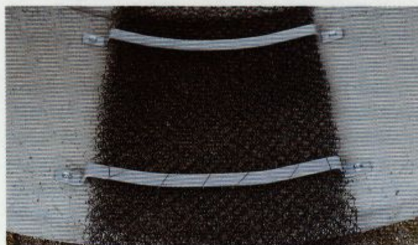
Enkammatmåtte fastgjort i betonrør f.eks. ved rørunderføringer.
