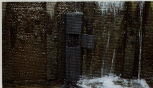
Ålepas ført frem i trækasse og fastskruet på styrtvæggen.
