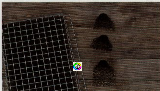
Stoppematerialet skal føres igennem hullerne og have forbindelse med selve passet, her er Enkamaten fastsyet i en trådkurv.
