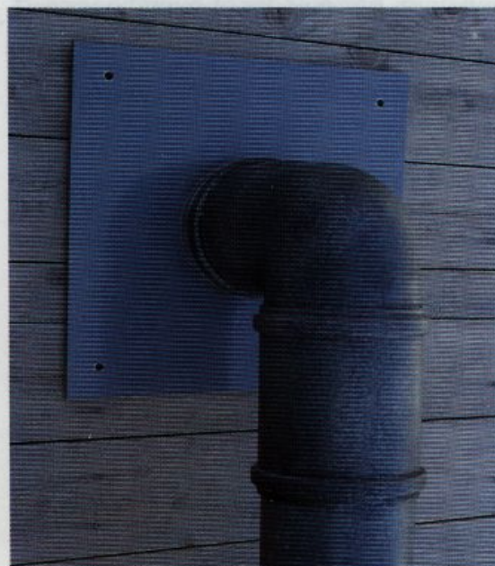
Fastgørelse af ålepasser udført i plastrør kan ske ved at montere en rørflange på styrtvæggen.
