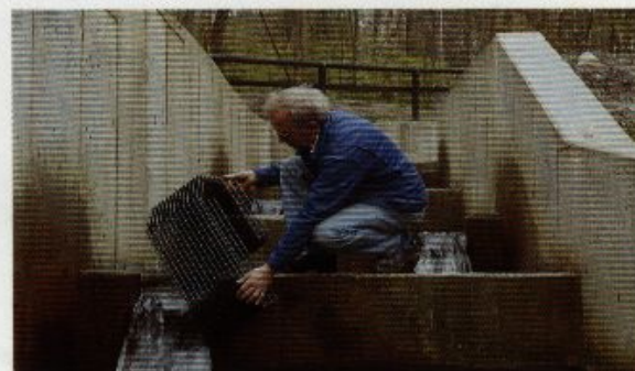
Dette ålepass er fremstillet som en trådkurv, formet efter trappens gennemgangsåbning og med fastsyet Enkammatmåtte klar til montering ned i bunden af åbningen.
