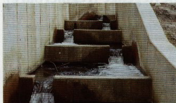
Fisketrapper er ikke passable for ål, og skal derfor være forsynet med ålepass.
