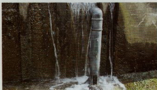
Ålepas ført frem i plastrør, opslidset i bunden og forsynet med inspektionslem.
