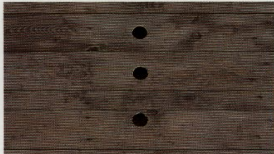
Gennemboring i styrtvæggen (min. 50 mm huller).
