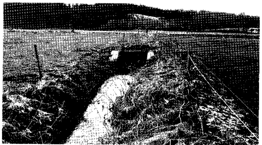
Figur 4.2 Mange vandløb er afbrudt af strækninger i rør.
