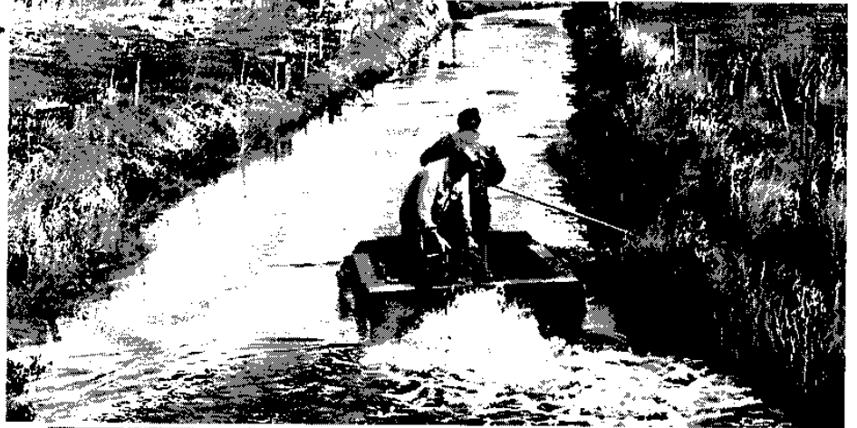
Figur 2.2 Grøden skæres med sejlede grødeskærer.
