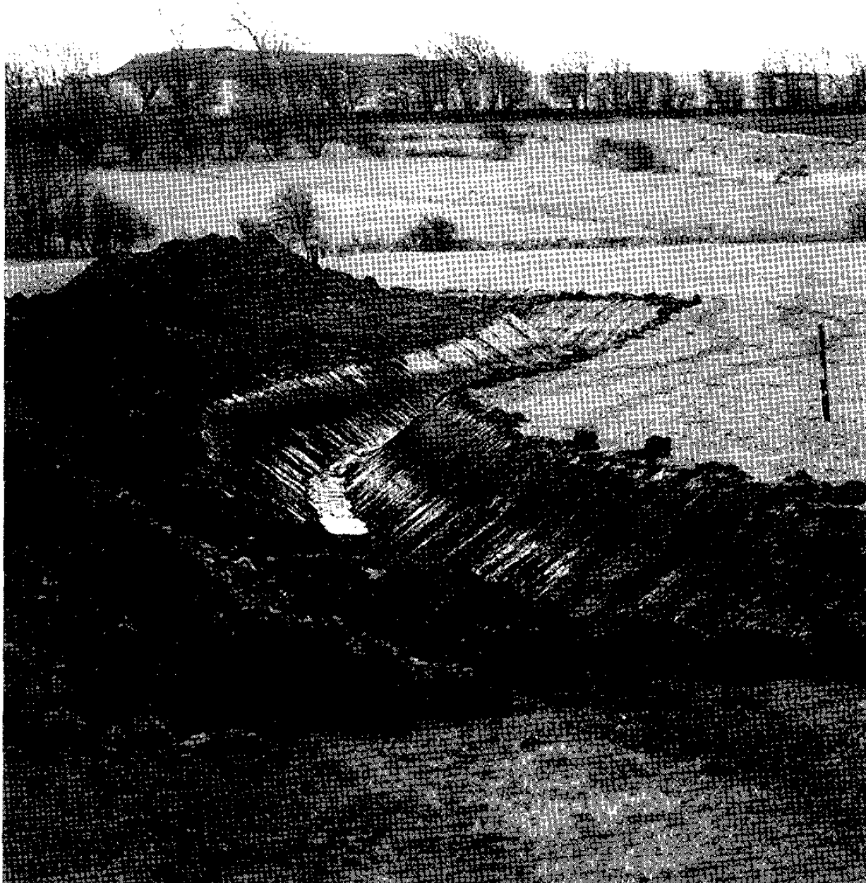
Figur 4.9 En slynget bæk bliver gravet ved siden af en rørlagt strækning af Isholm landgrøft. Foto Frank Eliasson
