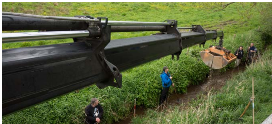
Udlægning af gydegrus direkte fra en lastbil med lang udlæggerarm.
