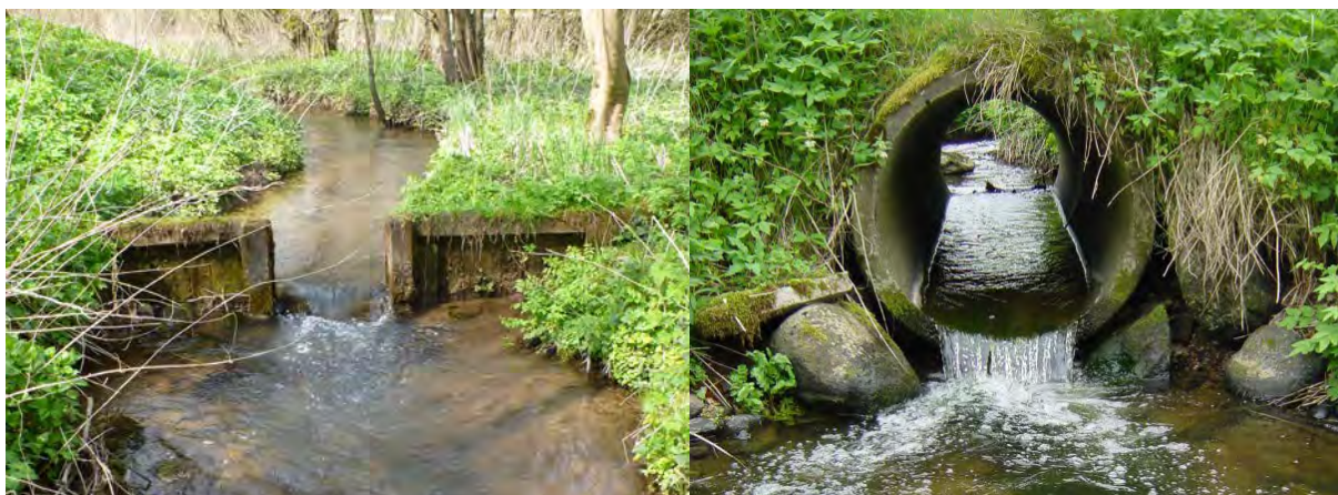
Udlægning af gydegrus kan forbedre passageforholdene mange steder, hvor små styrt og vejunderrør forhindrer, at faunaen kan foretage naturlige vandringer opstrøms.
