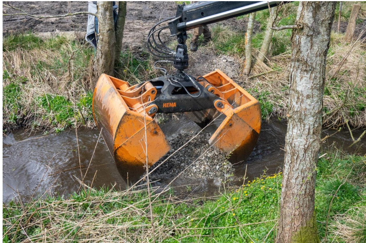
Udlægning af gydegrus fra lastbil med 14 m udlæggerarm
