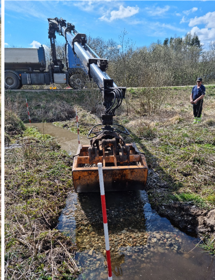
Udlægning af 37 cm gydegrus efter udgravning af sand (bundudskiftning med gydegrus)
