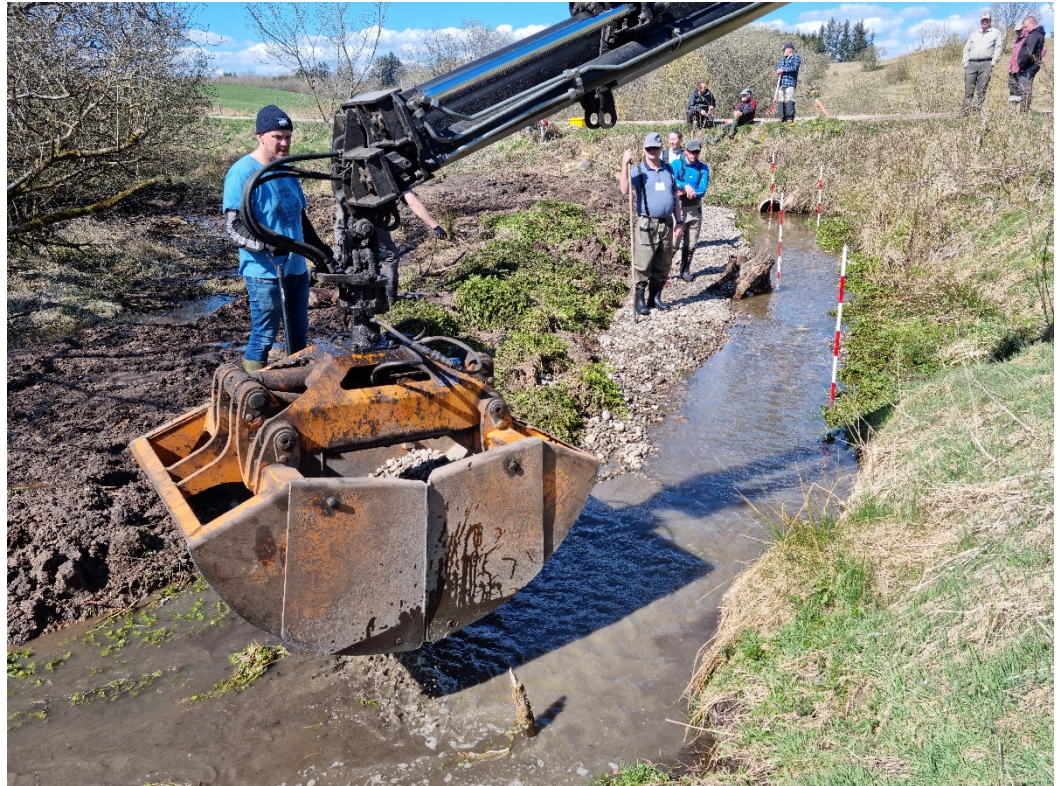
Udlægning af gydegrus fra lastbil med 14 m udlæggerarm
