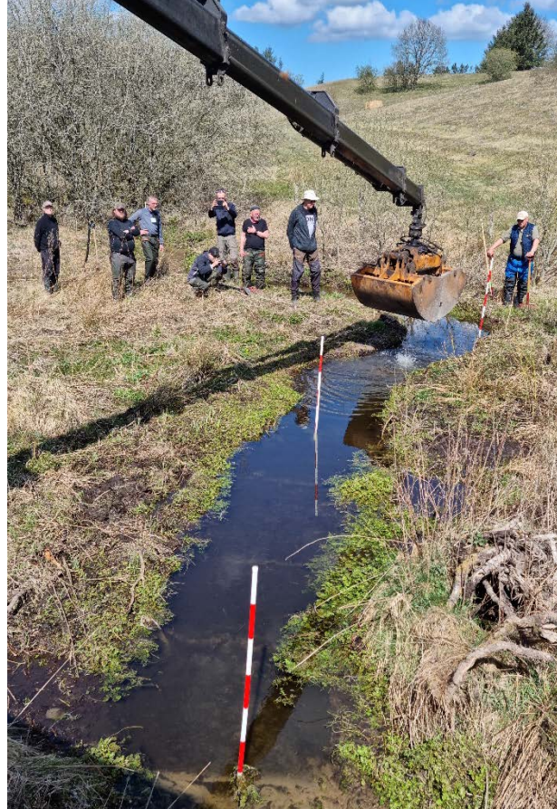
Udlægning af 37 cm gydegrus efter udgravning af sand (bundudskiftning med gydegrus)
