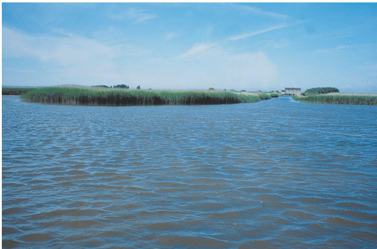
Ulvedybet: Pumpestationen og munden af Nørre Øxe Kanal.
