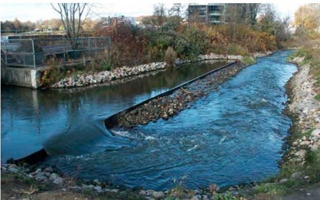
Overløbskant ved vandindtaget til et omløb ved Bygholm Sø, Vejle Amt (t.v., foto Jan Nielsen) samt overløbskant på den nedre del af et omløb i Ringkjøbing Amt (foto Per Søby Jensen).
