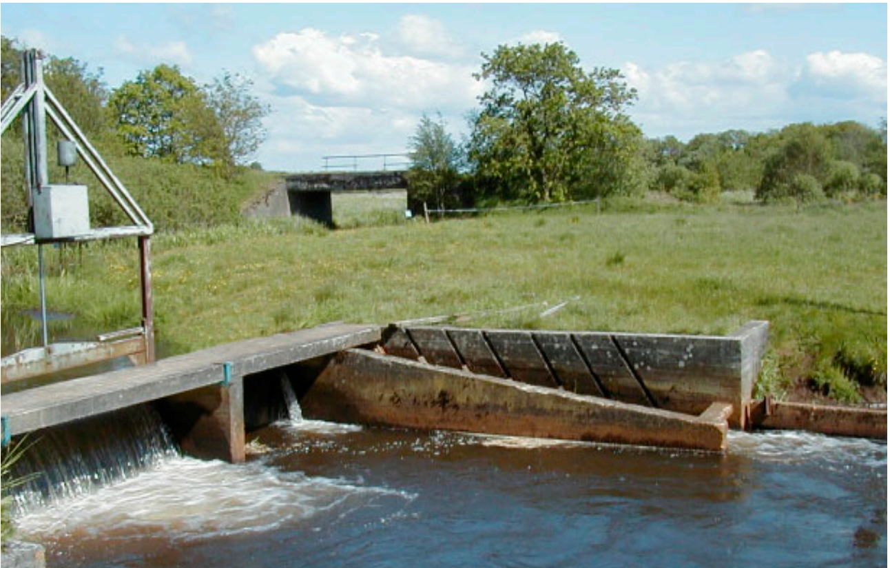
Fisketrappen fører kun en mindre del af den samlede vandføring og udmunder lidt neden for stemmeværket, det resulterer ofte i at fiskene forsøger at passere stemmeværket og ikke fisketrappen (foto Michael Deacon).
