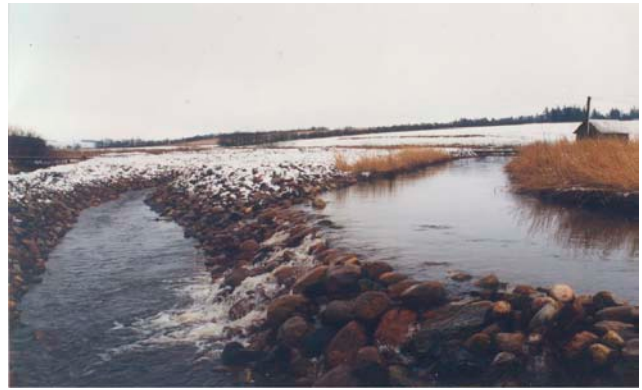
Overløbskant ved vandindtaget til et omløb ved Bygholm Sø, Vejle Amt (t.v., foto Jan Nielsen) samt overløbskant på den nedre del af et omløb i Ringkjøbing Amt (foto Per Søby Jensen).
