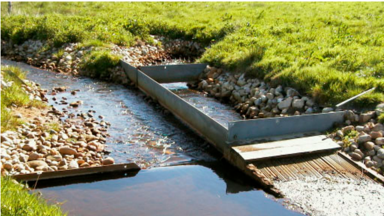
Eksempel på dambrugsindløb med lav stemmehøjde og vandindtag med analoge indløbstværsnit (foto Per Søby Jensen).
