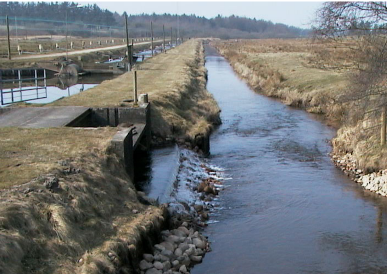
Afløb fra dambrug ombygget fra et punktformet afløb til afløb med bred difus overløbskant. Bemærk at afløbet er hævet over vandløbet (foto Per Søby Jensen)
