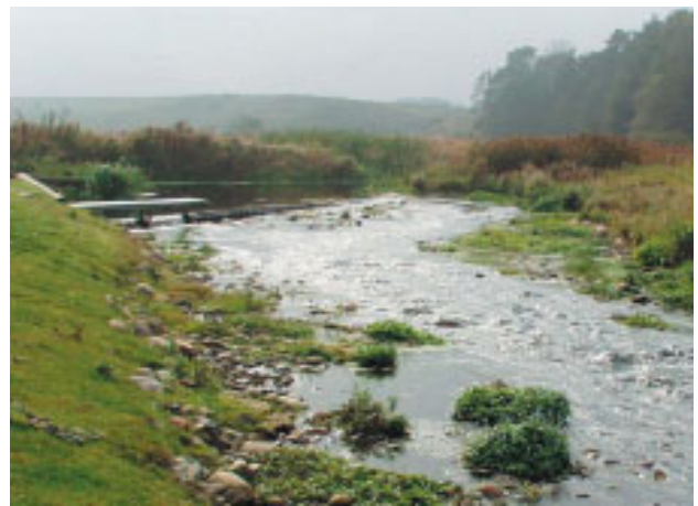
Faunapassage udformet som et stryg integreret i vandløbet (foto Ole Schwalbe Madsen).
