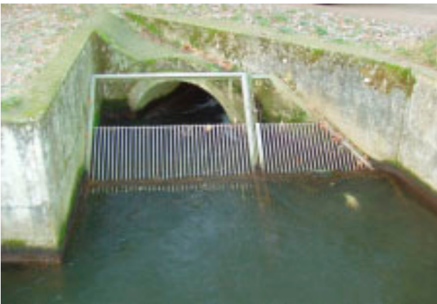
Afløbet fra et bundfældningsbassin viser, at fisk har gode muligheder for at springe over afgitringen. Ved høj vandstand er afristningen oversvømmet. Under disse forhold kan fiskene svømme direkte ind i bassinet (Foto Michael Deacon).
