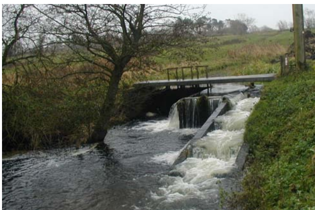
Fisketrappe af kammer typen. Bemærk den for fisk forvirrende frivandsafgivelse ved siden af fisketrappen (foto Margit Riis Andersen).
