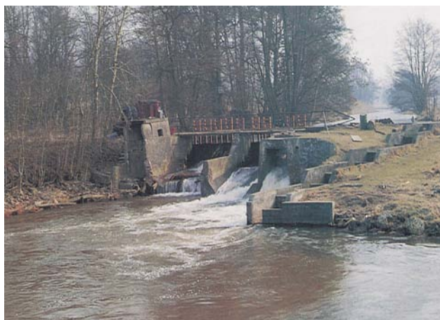
Opstemningen med fisketrapp ved Løjstrup Dambrug, inden den i juni 2001 blev fjernet og ombygget til stryg (foto Jan Nielsen t.v. og Århus Amt t.h.)
