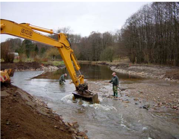
I februar 2002 blev opstemningen ved Vingsted Dambrug fjernet og ombygget til et stryg i hele vandløbets bredde (foto Vejle Amt).
