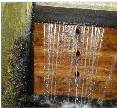
En passende vandtilførsel sikres ved, at der i styrtvæggen bores nogle 50 mm huller i en række over hinanden. Det er vigtigt, at stoppematerialet føres ud igennem hullerne.
