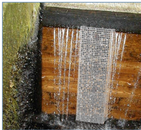
Kassen fyldes med det valgte stoppemateriale/Enkamate, og monteres så det dækker hullerne. Lad stoppematerialet/Enkamaten fortsætte hen over styrtets bund.
