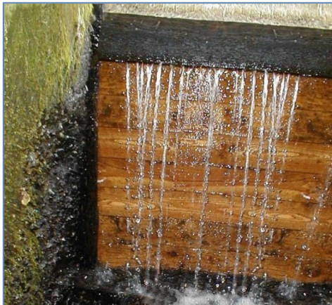
Et massivt stemmeværk, der spærrer i hele vandløbets bredde.
