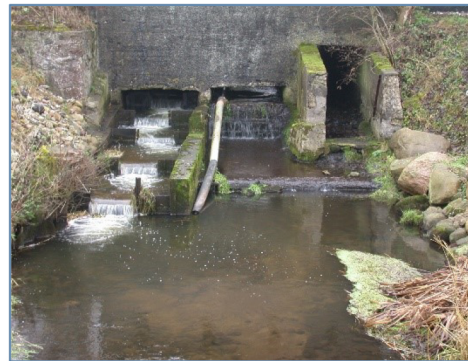
På grund af den voldsomme vandbevægelse i styrtlejet, er det her nødvendigt at forlænge ålepasset ned forbi styrtlejet og videre ud til udmundingen nedenfor.
