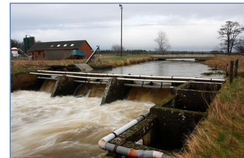
Det kan være nødvendigt at forlænge et ålepass over en lang strækning, før der er smult vand.
