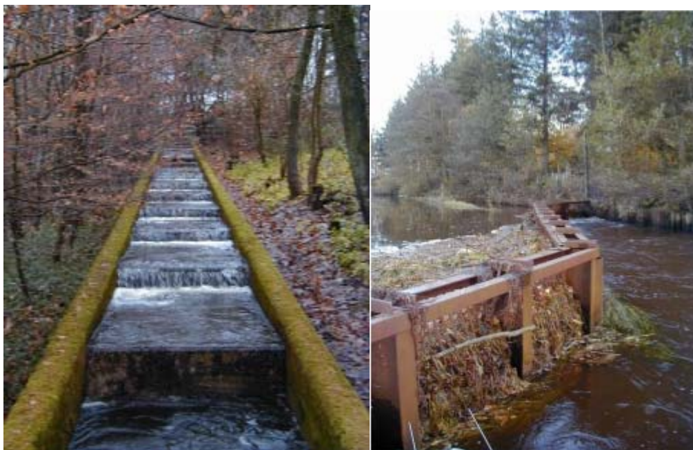
Fig. 13. Fisketrappen ved Karlsgårdeværket i oktober med overløb (tv) og grødespærre ved indløbet til Karlsgårde Sø, hvor grøden støver vandet op mod 1 meter (th).
