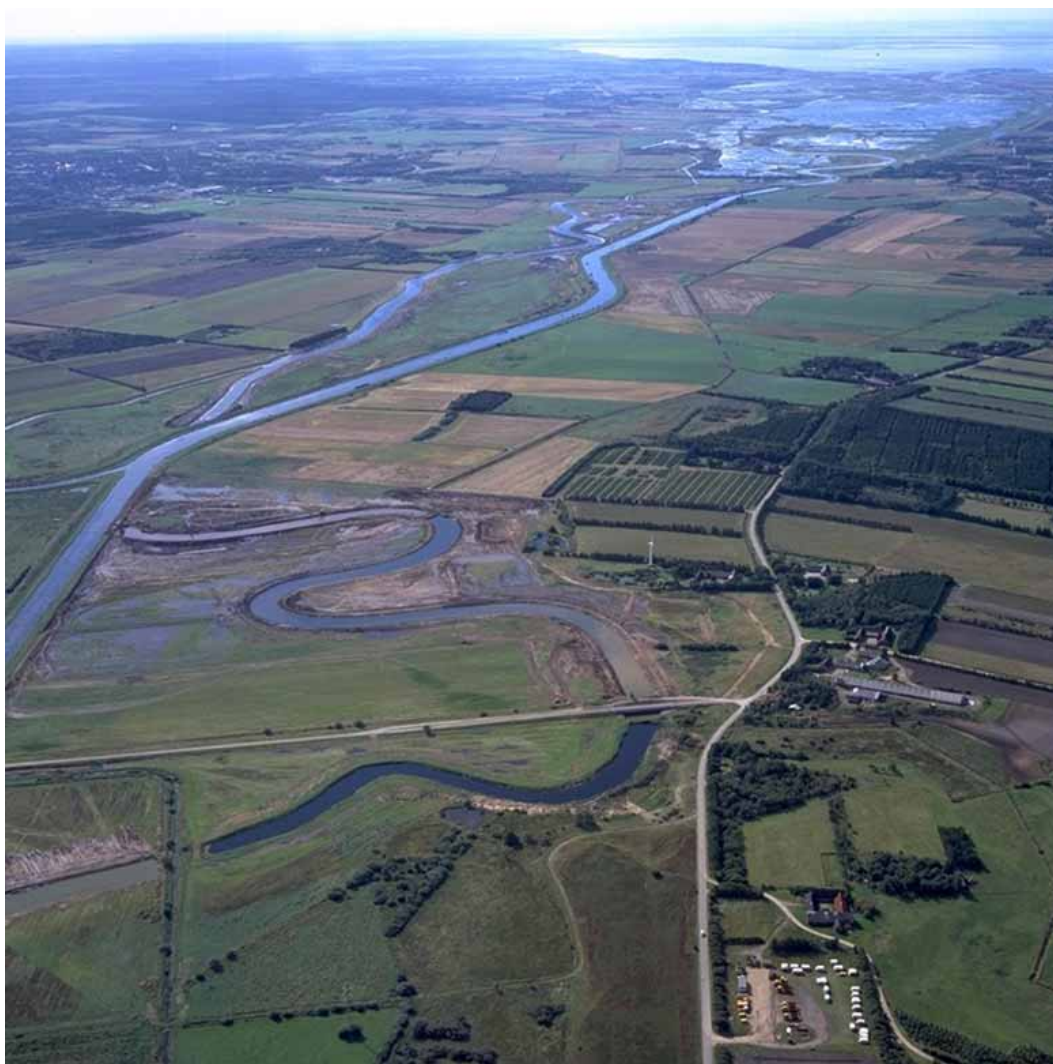
Figur 2. Anlægsarbejdet ved Albæk. Både det gamle og det nye åløb kan ses (Foto: Povl Toft).
