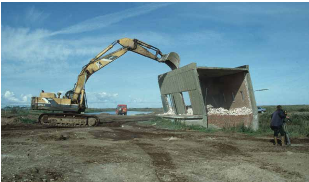
Figur 5. Nedrivning af pumpestation (Foto: Marianne Linnemann).
