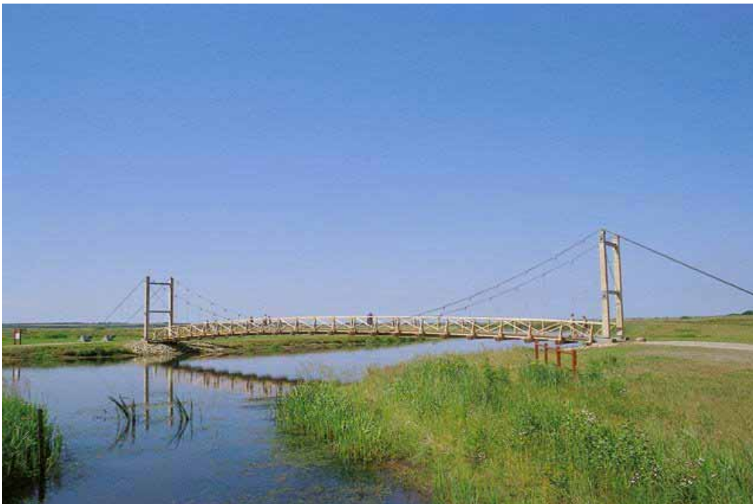
Figur 6. Ny gangbro over Skjern Å (Foto: Marianne Linnemann).
