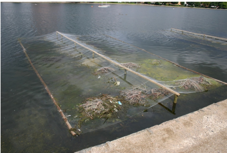
Figur 4. Et kunstigt lavtvandsområde i Peblingsøen i København. Det består af trævægge (størrelse 5 x 10 m) på søbunden fyldt op med sand. Man ser rosetterne af grantræ, som fungerer som skjul i stedet for vandplanter. Overdækningen med hønsenet forhindrer søens svaner i at stå på området og æde grangrenene.
