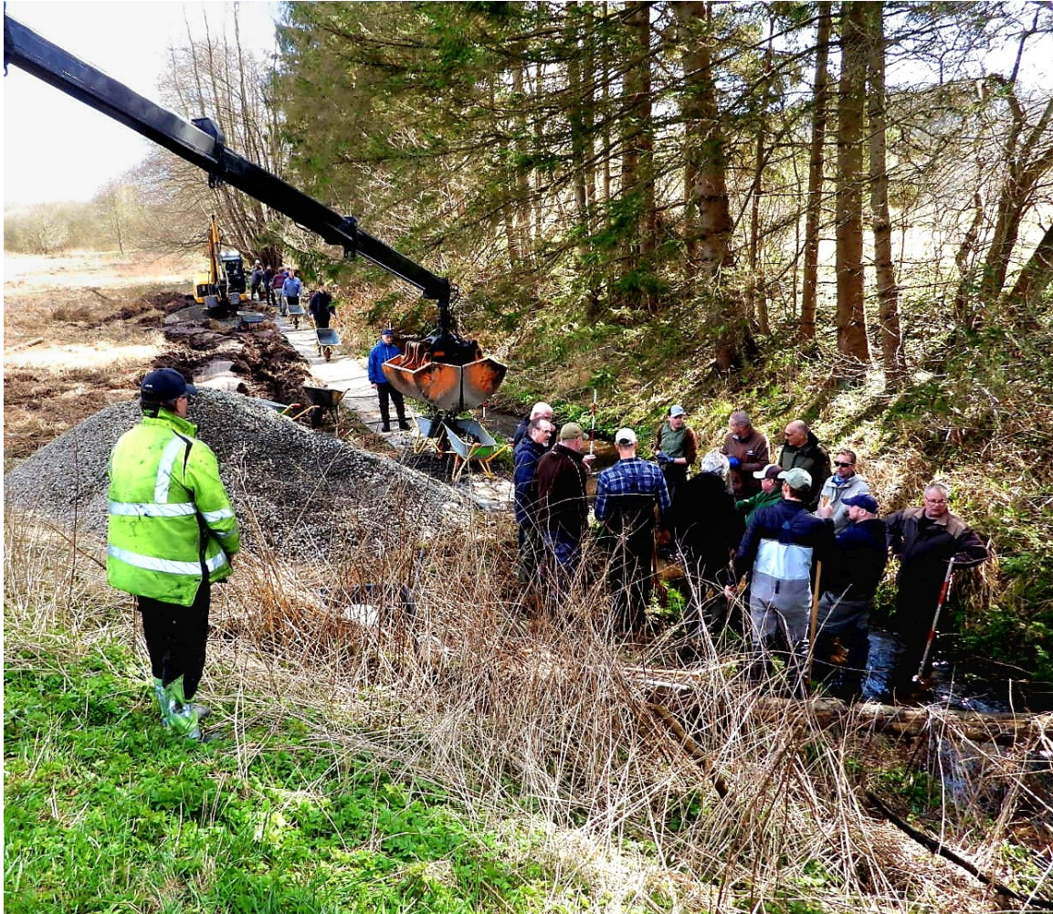
Udlægning af gydegrus fra lastbil med 14 m udlæggerarm
