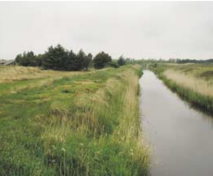
Reguleret vandløb med diger, som effektivt forhindrer oversvømmelse
