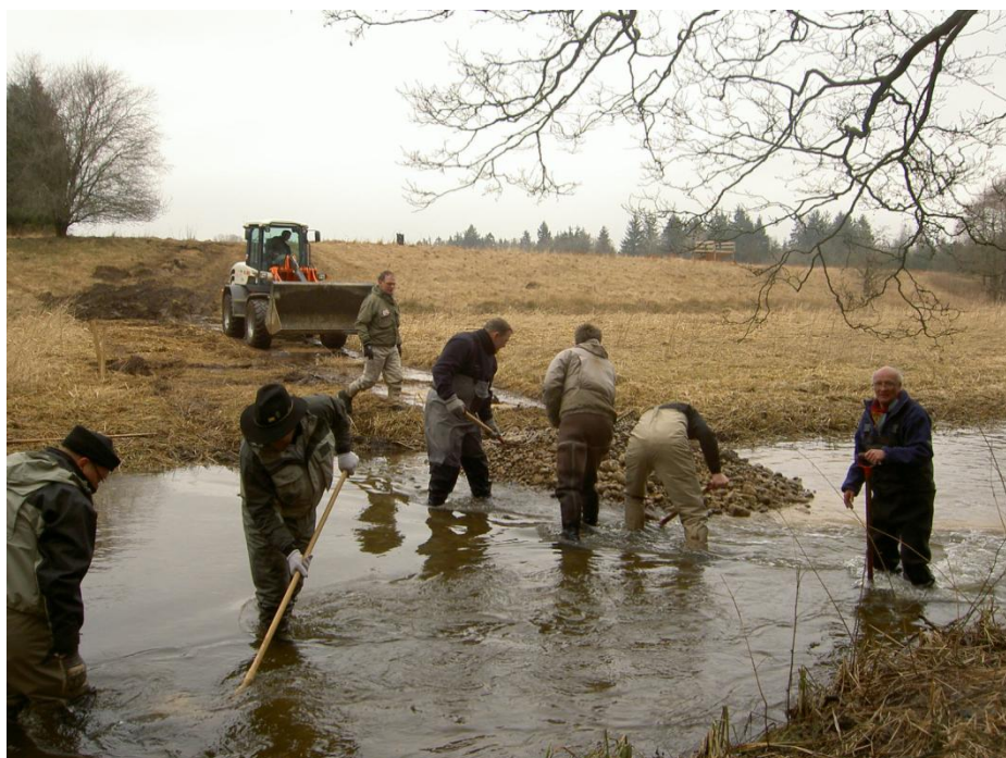
Grusudlægning i mindre vandløb
