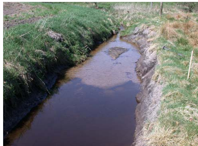
Figur 4: Til venstre ses skitse over et sandfangs konstruktion (gengivet fra Nielsen, 2003). Til højre et foto af et nyetableret sandfang, hvor det tydeligt ses, hvordan sandet vandrer ind i sandfanget og tilbageholdes.
