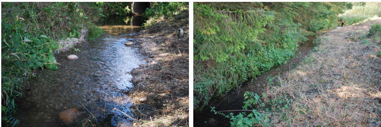
Eksempel på hævnngen af vandstanden i en vejunderføring ved udlægning af gydebanker (Nielsen & Sivebæk 2015)
